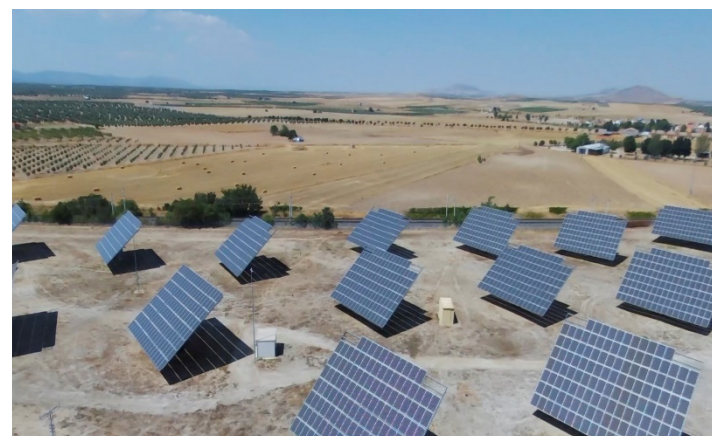
Vista panorámica de nuestra planta fotovoltaica.
